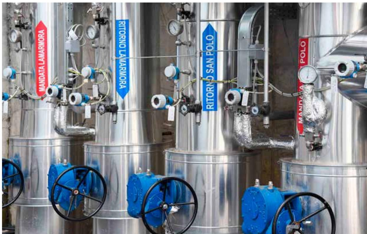
Particolare del nodo di interconnessione con il teleriscaldamento
